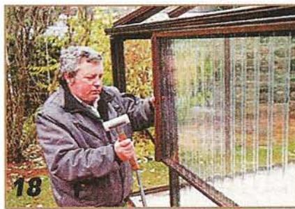
В боковые детали оконной рамы вставляют дистанционный профиль для остекления стены (и соответственно крыши) с последующим набиванием на них нащельников.
