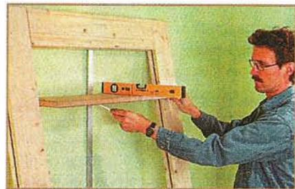
Раму этажерки устанавливают так, чтобы расстояние между её основанием и стеной было равно 360 мм. Уложенные на раму полочки тщательно выверяют по уровню и делают отметку на металлической полосе по нижней кромке каждой полочки. Затем полосу временно снимают и по меткам крепят к ней винтиками с гаечками уголки.
