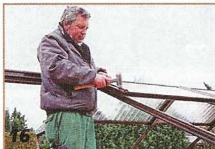
Плиты остекления снабжают металлическими профилями. На все стропила пластииковым молотком набивают нащельники.
