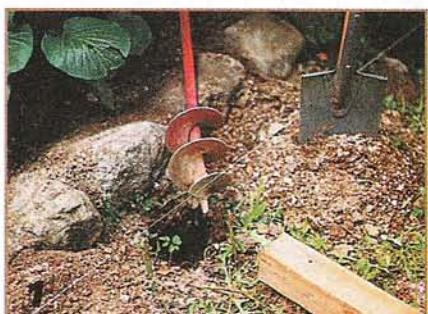
**По натянутому шнуру определяют положение стоек. Ямы под фундамент бурят специальным буром.**
