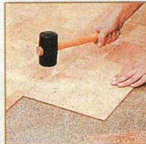
**Пробковый паркет и плитку приклеивают к основе всей поверхностью. В зависимости от вида клея его наносят на тыльную сторону покрытия или на основу. Элементы покрытия соединяют встык. Одного только прижатия плитки к основе руками подчас бывает недостаточно. Лучше плитки ещё обстучать резиновым молотком.**
