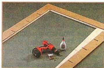
Детали среднего слоя (из плиты МДФ) крепят на клею и шурупах к доскам лицевого слоя так, чтобы панели из МДФ перекрывали стыки досок.
